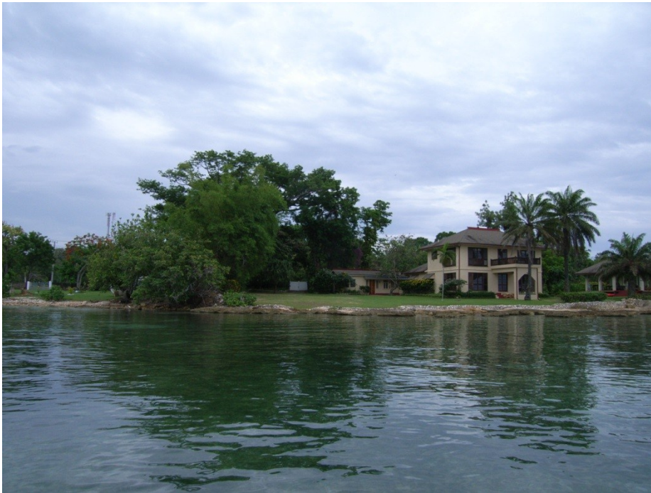
Appendix A- 5. RIMG0020 - Riprap.
