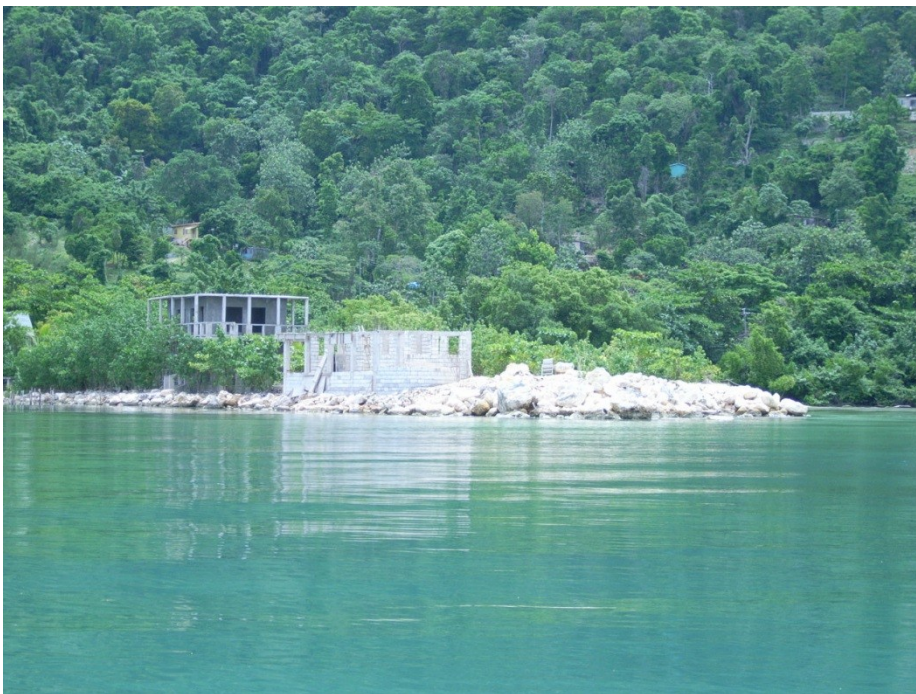
Appendix A- 21. RIMG0137 - Riprap.
